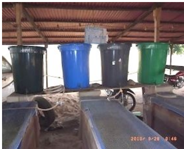
Figure N° 7 : Stockage de l'eau du réseau public de distribution (SONEB) avant utilisation
